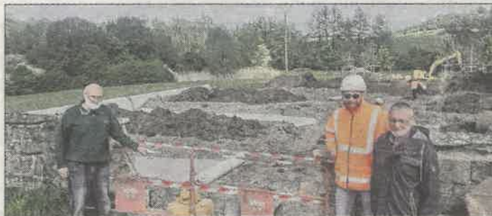
Louis Odille, chef de chantier de Colas France, entre Jean Kieffer, maire (à dr.), et Marc Weitten, adjoint (à g). devant le vaste chantier qui vient de démarrer au cimetière communal. Photo RL
