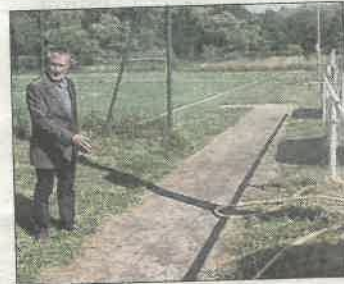
Le maire, Jean Kieffer, désigne l'emplacement du puits qui facilitera l'arrosage des pelouses. Les travaux s'élèveront à 9 300 €.
