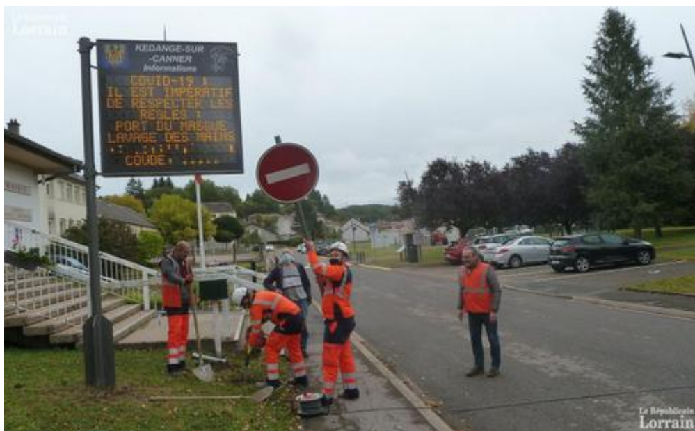
Devant la mairie, un panneau « sens interdit » vers les écoles a été installé ! Photo RL
