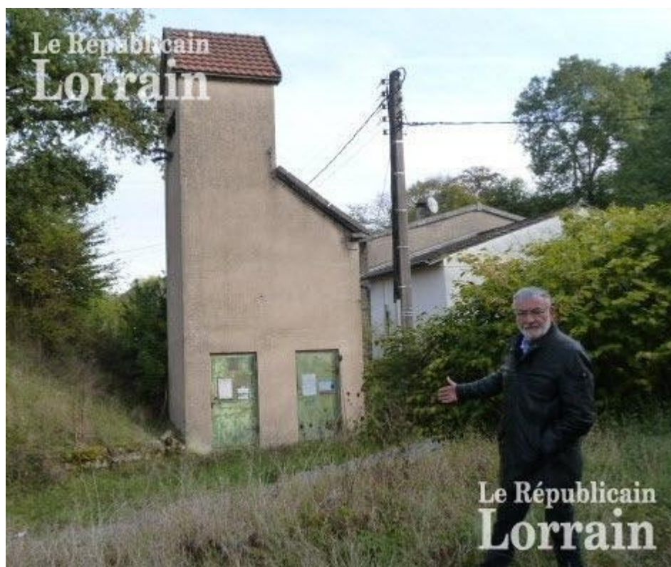
La municipalité a le projet de modifier le transformateur situé à côté de l'ancien abattoir. Photo RL
